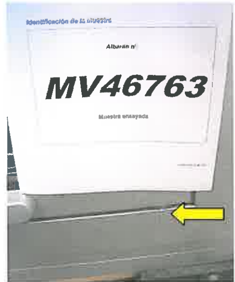
Zona filtración de agua
